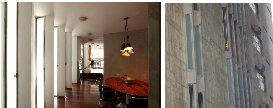
Figuras 14 e 15 – Vistas interna e externa das faixas de vidro laterais, que permitem luz natural constante Fonte: Escritório Sub.Estúdio (2012)
