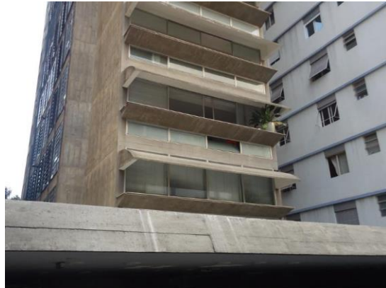
Figuras 18 e 19 – Vistas interna e externa, respectivamente, do toldo e peitoril de concreto aliados ao pano de vidro Fonte: Escritório Sub.Estúdio (2012)
