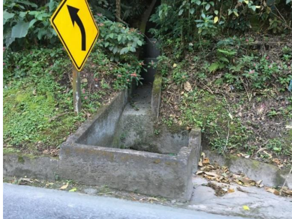
Figura 6- Interligação entre escada d'água e galeria subterrânea
