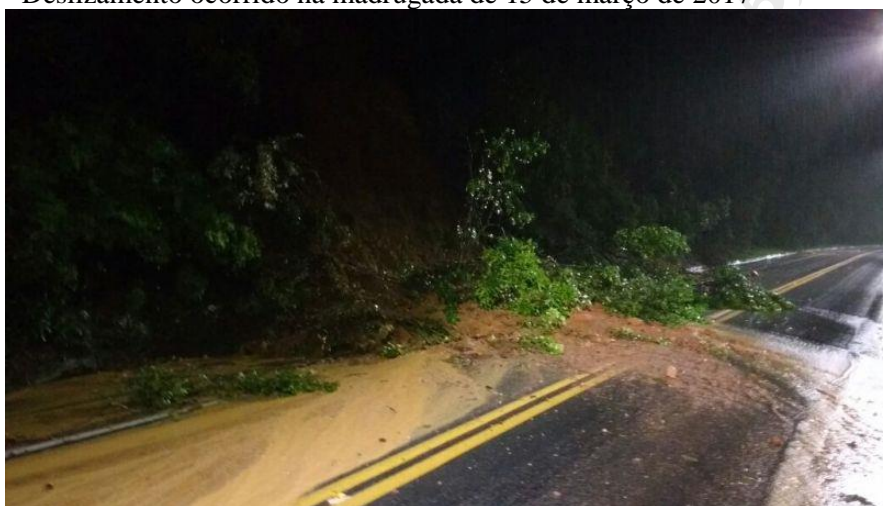
Figura 17- Deslizamento ocorrido na madrugada de 15 de março de 2017
