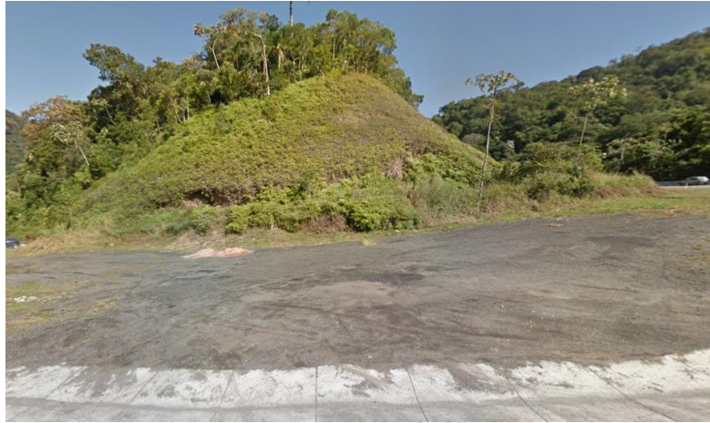
Figura 9- Trecho da Rodovia dos Tamoios entre o km 77 e o km 78 antes das obras de retaludamento
