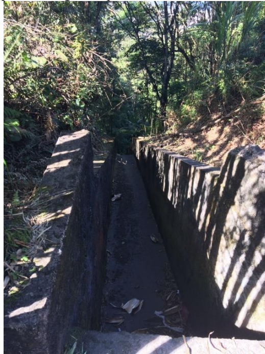
Figura 5- Escada d'água para drenagem superficial do terreno
