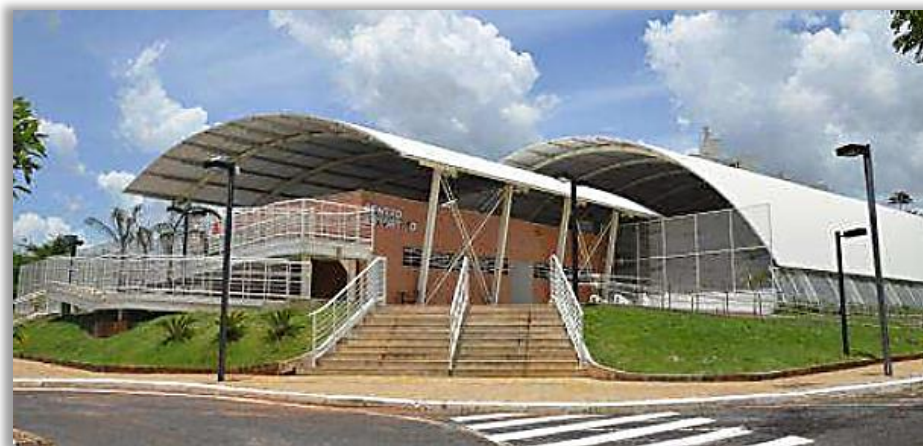
Figura 1: Exemplo de estrutura com arcos estruturais (centro esportivo da Universidade Federal de Uberlândia/MG).
