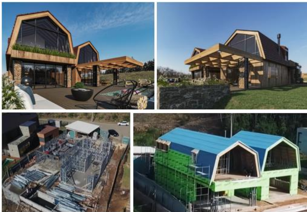
Figura 1: Estruturação de uma casa em LSF .
