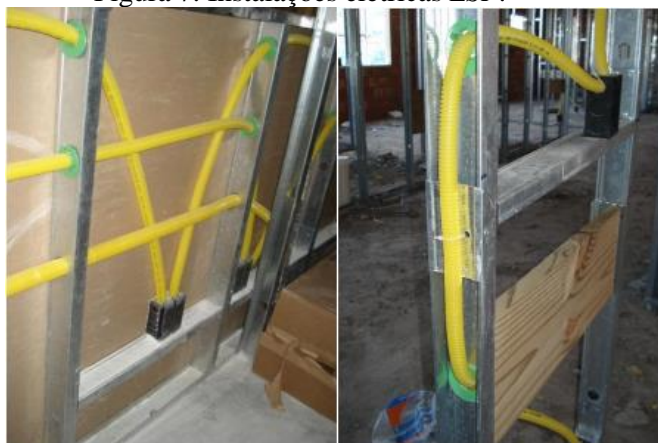
Figura 7: Instalações elétricas LSF .
