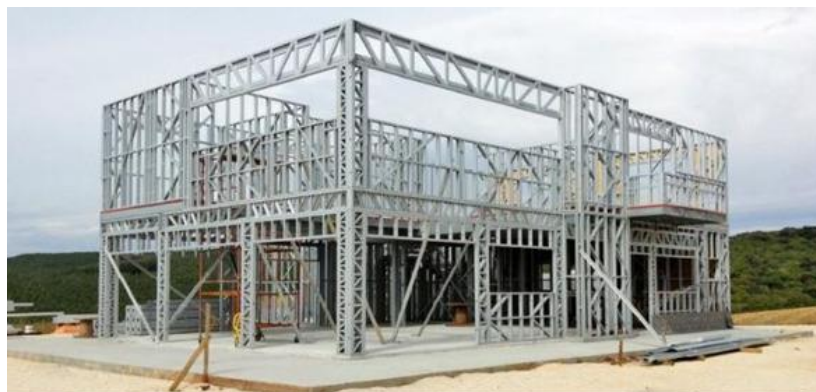
Figura 2: Concepção estrutural de uma residência em LSF .
