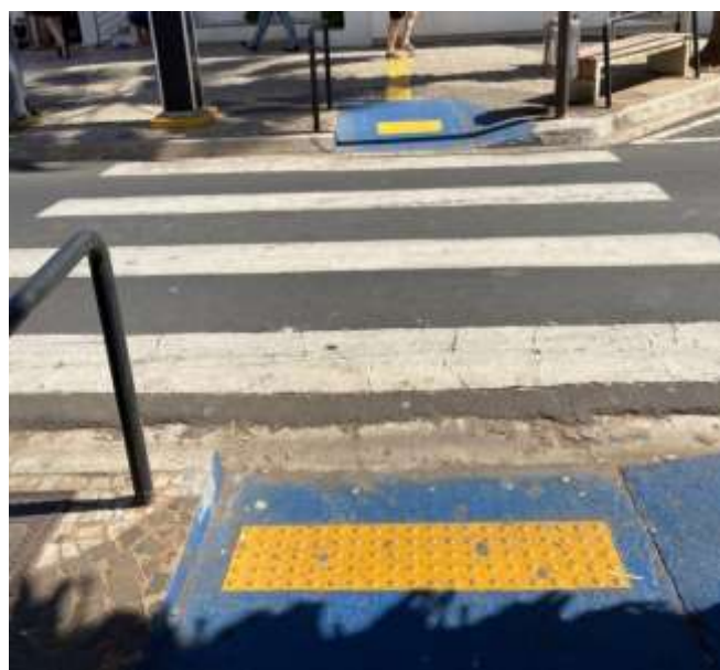
Figura 9: Faixa de pedestre com rampa de acessibilidade e piso tátil situada em um dos cruzamentos de estudo
