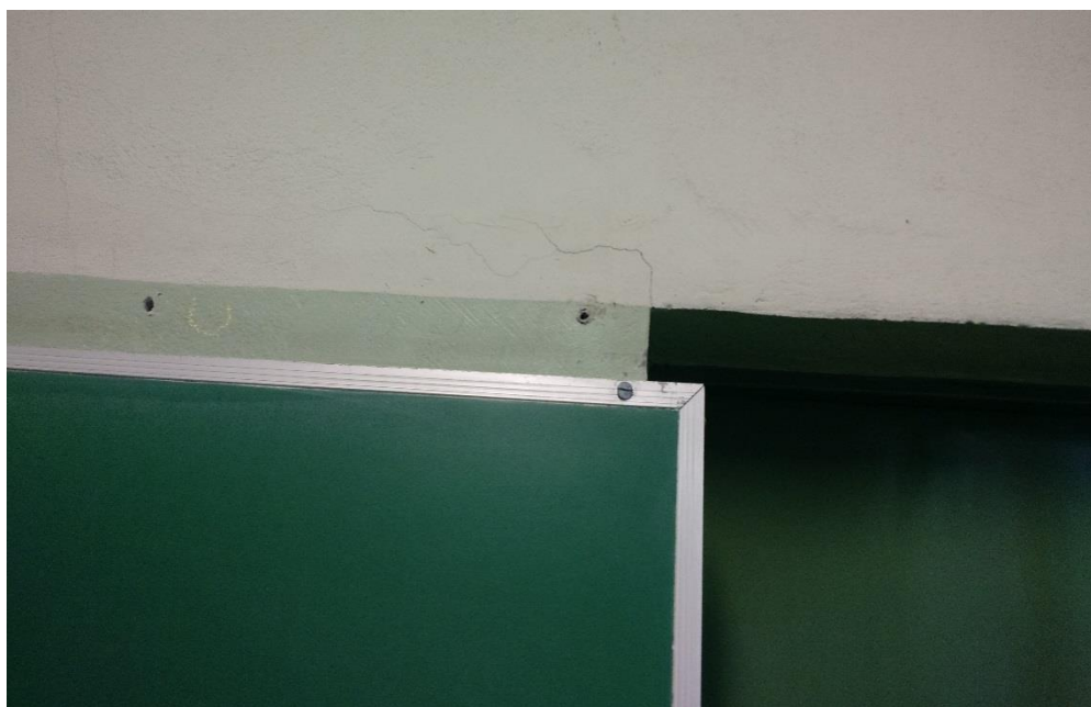
Figura 6 - Fissura inclinada que se desenvolve a partir do vértice de abertura da porta
